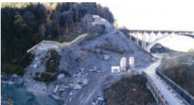
IM Herbst 2020 konnten die bergmännischen Vortriebsarbeiten Richtung Süden abgeschlossen werden. Seit Baubeginn wurden ausgehend vom Zufahrtstunnel in Mauls Richtung Süden die beiden 5km langen Abschnitte der Haupttunnelröhre mittels Sprengvortrieb ausgebrochen. Richtung Norden/Brenner fräsen sich insgesamt drei Tunnelmaschinen durch den Berg. Allen voran die TBM im Erkundungsstollen. Lediglich 3,6 km trennen die Fabrik untertage noch von der Staatsgrenze am Brenner.
