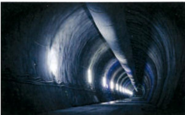
Nach dem erfolgreichen Durchschlag des 16,7 km langen Erkundungsstollen im Juli 2020 sind sämtliche Vortriebsarbeiten in dem Baulos Tulfes-Pfons abgeschlossen. Derzeit laufen die Demontgearbeiten der Tunnelbohrmaschine.
